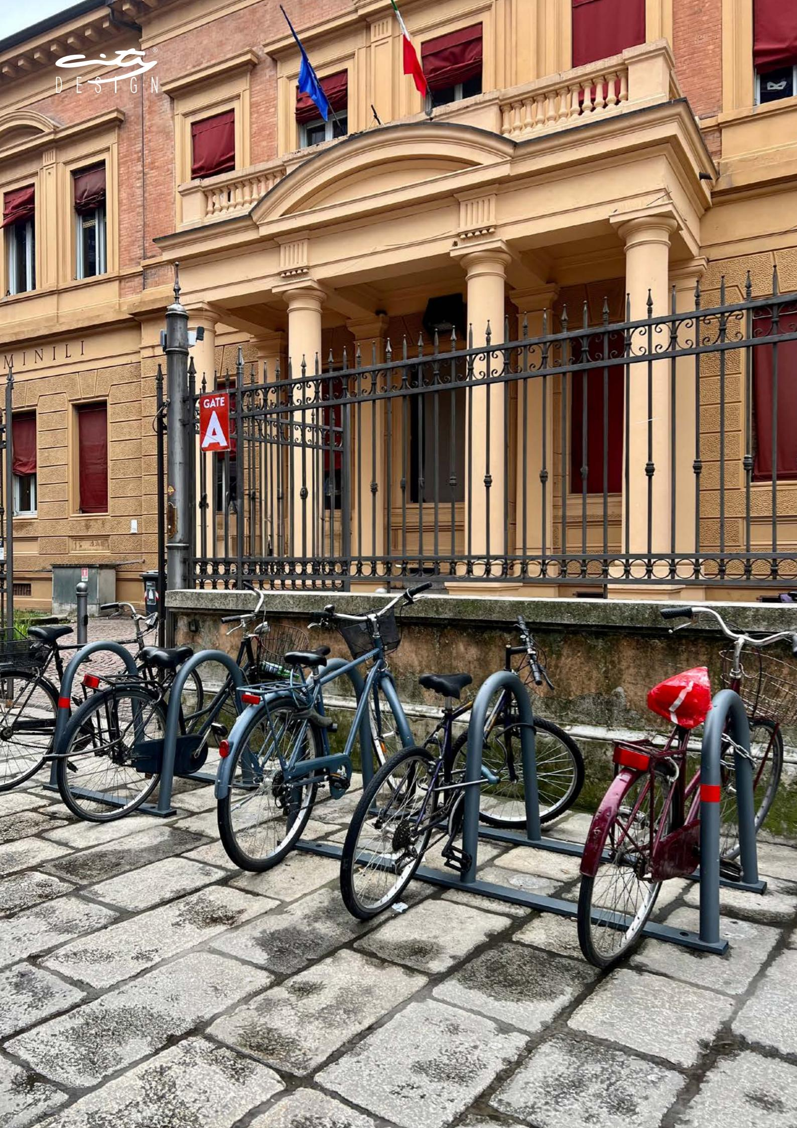
Collezione di portabici realizzati da due orizzontali in tubolare rettangolare di acciaio su cui sono saldati due, tre o quattro archi in tubolare tondo di acciaio.
