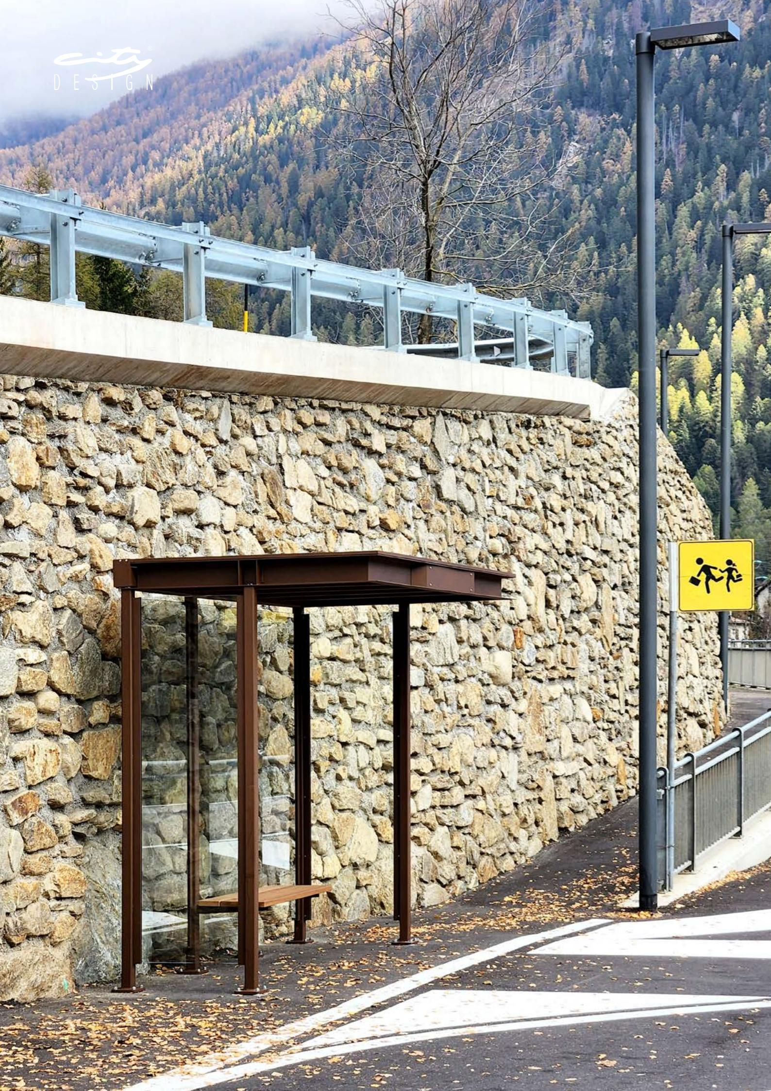
Pensilina a tre o quattro moduli, costituita da una struttura con montanti in tubolare di acciaio con piastre base in lamiera di acciaio e con copertura piana.
